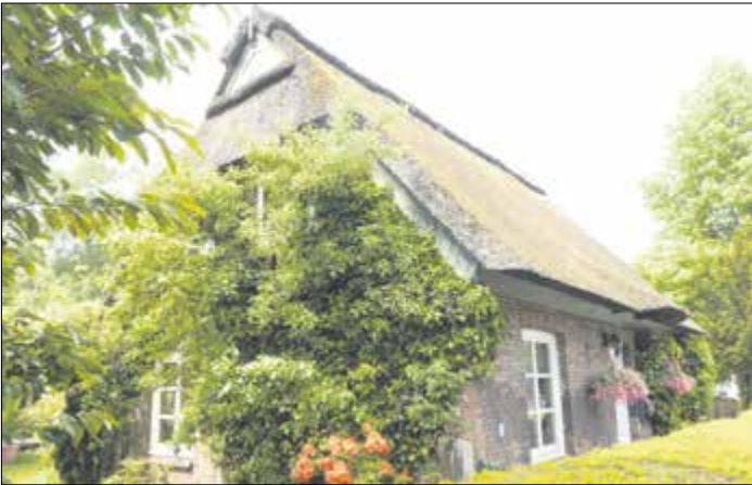
Auch dieses Gebäude bekommt ein neues Dach
