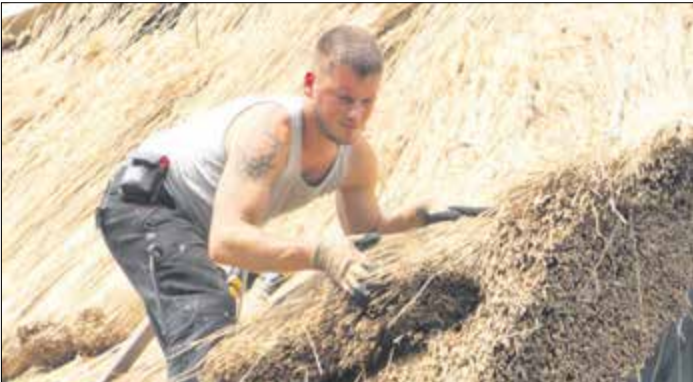
Das Decken eines Reetdaches ist immer noch ein „Hingucker“
