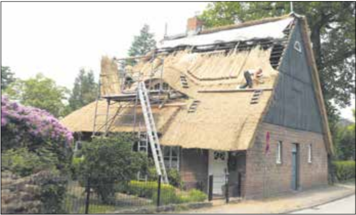
Auf diesem Nebengebäude an der Langelohstraße wird das Reetdach gedeckt
