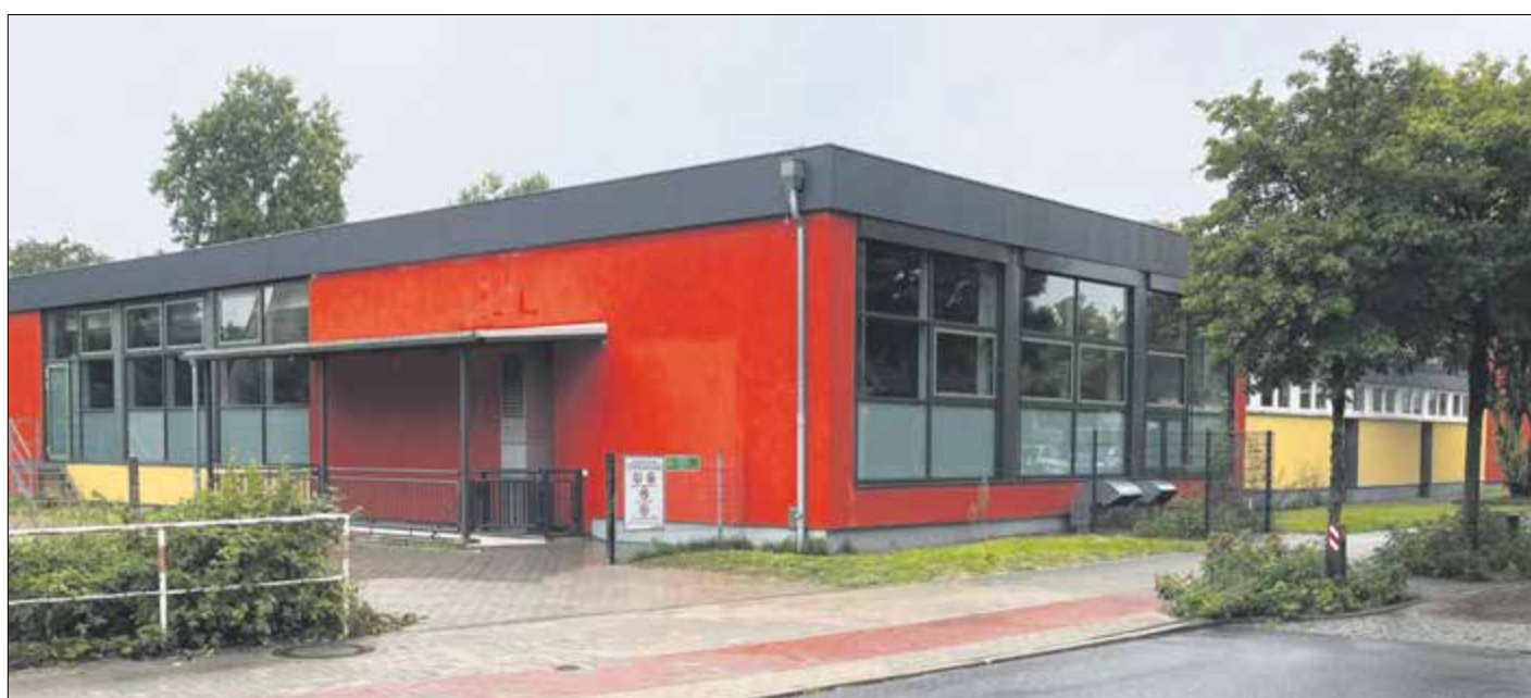
Die Schwimmhalle der Gorch-Fock-Schule in Schenefeld-Siedlung
