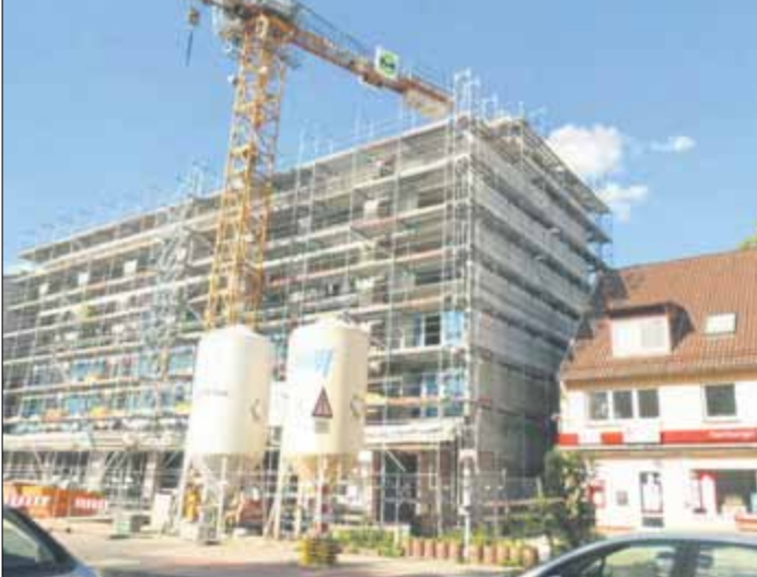
An vielen Stellen wird in der Luruper Hauptstraße gebaut. Dieses Foto ist aus dem letzten Jahr.
