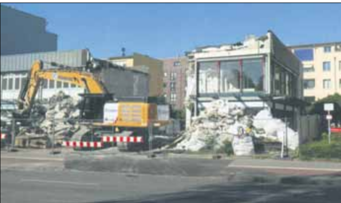
An vielen Stellen wird in der Luruper Hauptstraße gebaut. Dieses Foto ist aus dem letzten Jahr.
