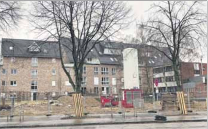
An der Sülldorfer Landstraße entstehen schon Wohnungen
