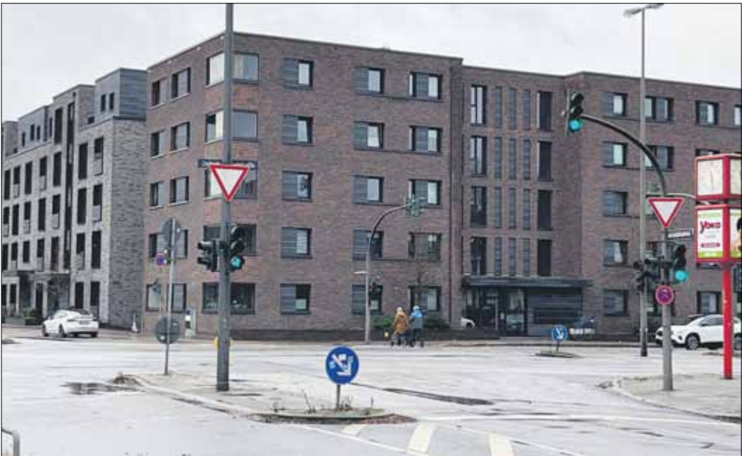
An der Osdorfer Landstraße wurde schon massiv gebaut
