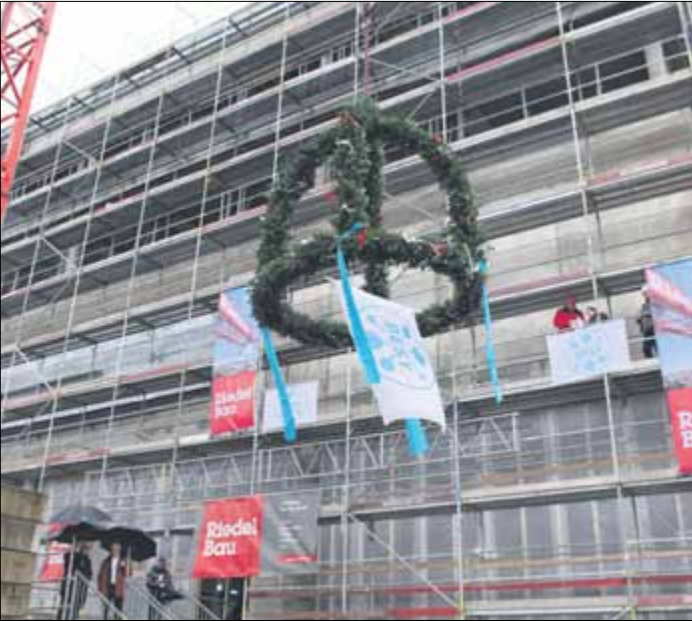
Richtkrone vor dem DESYUM: Nachdem der Polier ein selbstverfasstes Gedicht zur Fertigstellung des Rohbaus des DESY-Besuchszentrums vorträgt, wird unter den Augen von Hamburgs Wissenschaftssenatorin Katharina Fegebank und DESY-Direktor Helmut Dosch (links im Hintergrund) die Richtkrone gehisst.
