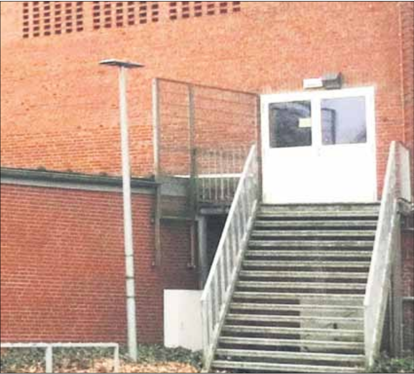
Noch ist die Aula u.a. über diese steile Treppe erreichbar
