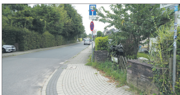
Ab Oktober 2024 wird es in Schenefeld Verkehrsbeeinträchtigung in den Straßen Kykerweg und Stettiner Straße geben. Die Fahrbahnen müssen dringend saniert werden.
