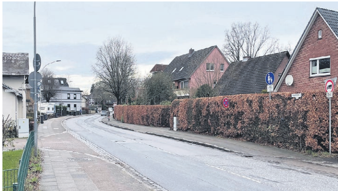
Ein Teilstück der Hauptstraße in Schenefeld Dorf muss komplett saniert werden.
