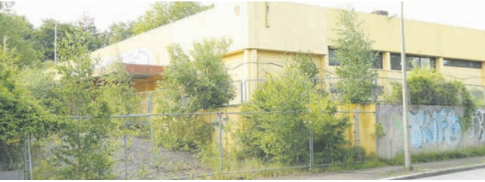
In diesen Gebäuden waren auch schon einmal Flüchtlinge untergebracht
