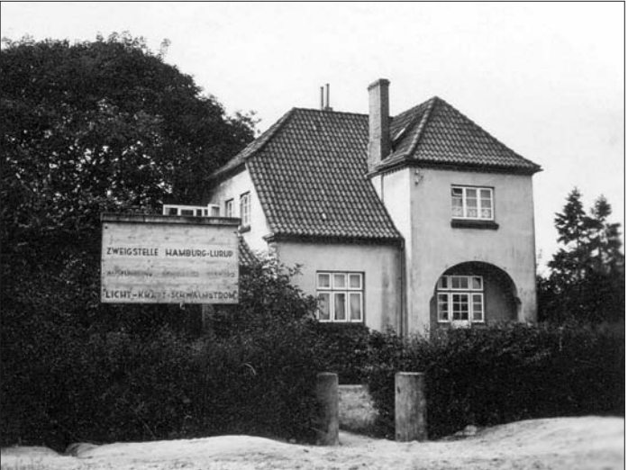
Dieses Gebäude stand Ecke Brooksheide. Heute steht hier das „FAMA-Gebäude“. (Luruper Hauptstraße Nr. 247)
