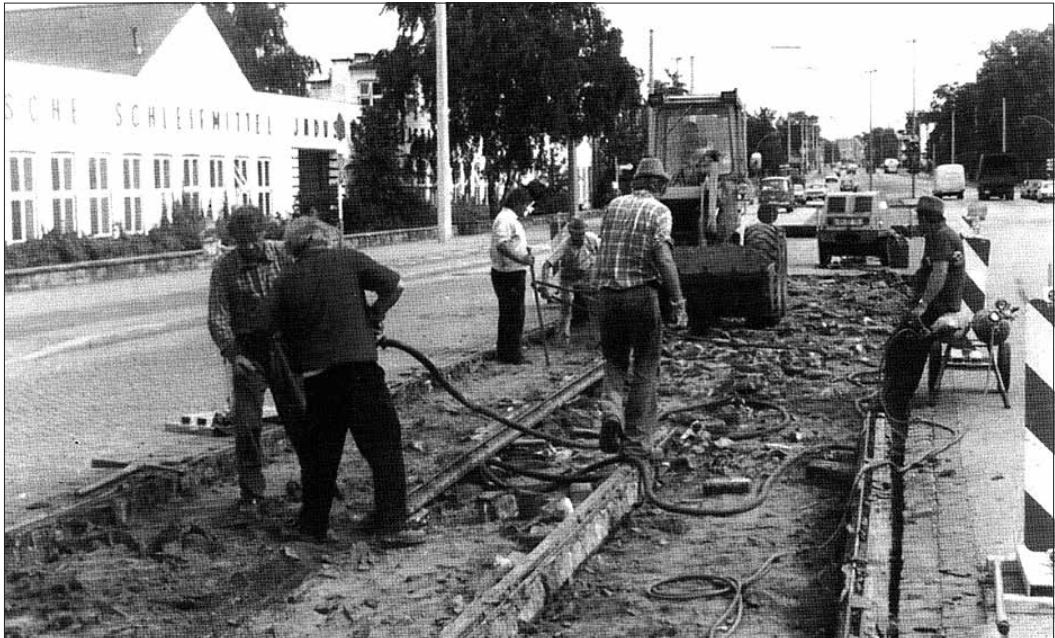
Die Straßenbauer und Steinsetzer schufen eine Prachtschraße in Lurup. Kleingranit und Pflastersteine wurden verarbeitet. Das Foto entstand auf der Luruper Hauptstraße/Ecke Lüttkamp.
