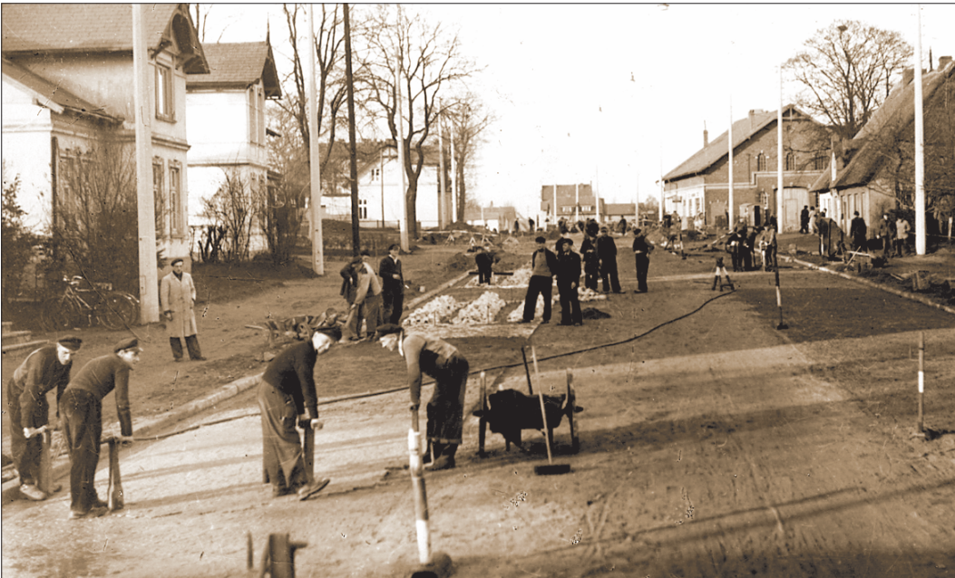
Die Straßenbauer und Steinsetzer schufen eine Prachtschraße in Lurup. Kleingranit und Pflastersteine wurden verarbeitet. Das Foto entstand auf der Luruper Hauptstraße/Ecke Lüttkamp.
