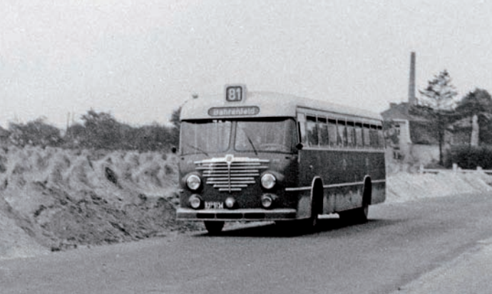
Linienbus auf Höhe des heutigen Schenefelder Platzes, das Kornfeld wurde ein letztes Mal geerntet, am Straßenrand sind die ersten Tiefbaumaßnahmen für die Straßenbahnkehre sichtbar, 1955
