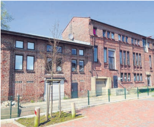
Halstenbeker Chaussee 7 – Leimfabrik von Carl Groenewaldt. Im Gebäude aus dem Jahr 1917 wurden bis in das Jahr 1968 Produkte für die Holz- und Papierindustrie hergestellt. Lange Jahre auch Fabrik für Jutesäcke.
