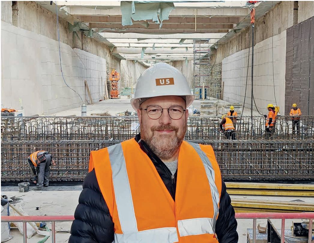
Archivbild: Frank Schmitt machte sich auf der Baustelle der U5-Haltestelle City Nord ein Bild vom Baufortschritt der neuen U-Bahn-Linie.
