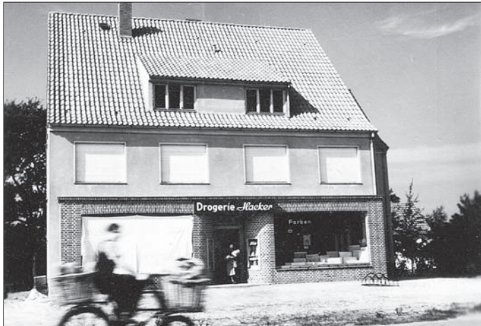
Nach der Drogerie Hacker war das Küchenstudio „Kubowski & Witte“ dort ansässig. Jetzt befindet sich dort die Post. (Luruper Hauptstraße Nr. 199)
