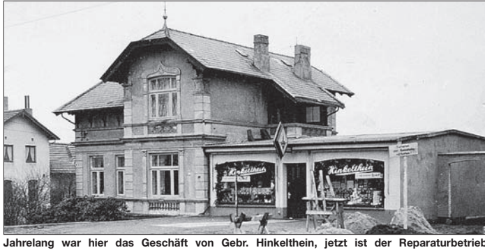
Jahrelang war hier das Geschäft von Gebr. Hinkelthein, jetzt ist der Reparaturbetrieb Automeister Bienek dort beheimatet. (Luruper Hauptstraße Nr. 50)
