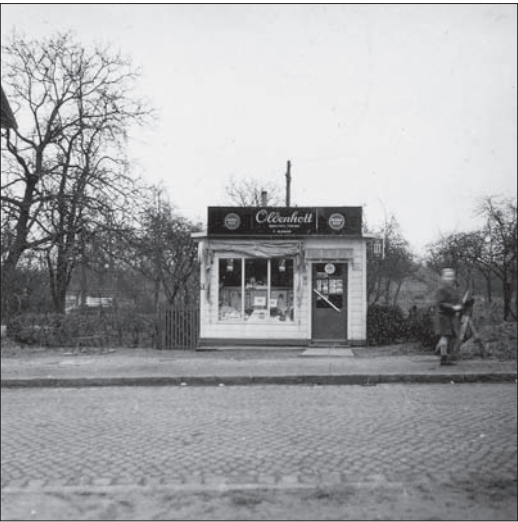
Neben dem heutigen Friedhofseingang dieser Kiosk, Luruper Hauptstraße 42.
