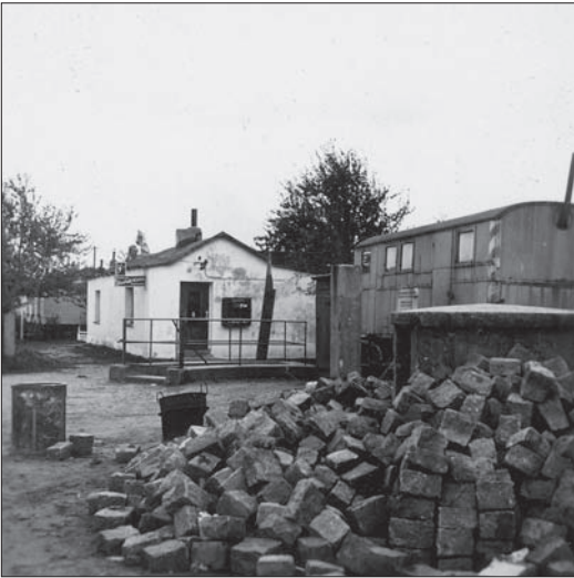
An der Ecke Engelbrechtweg/Luruper Hauptstraße war ein Tiefbunker. Daneben ein Lotto-Foto Geschäft.
