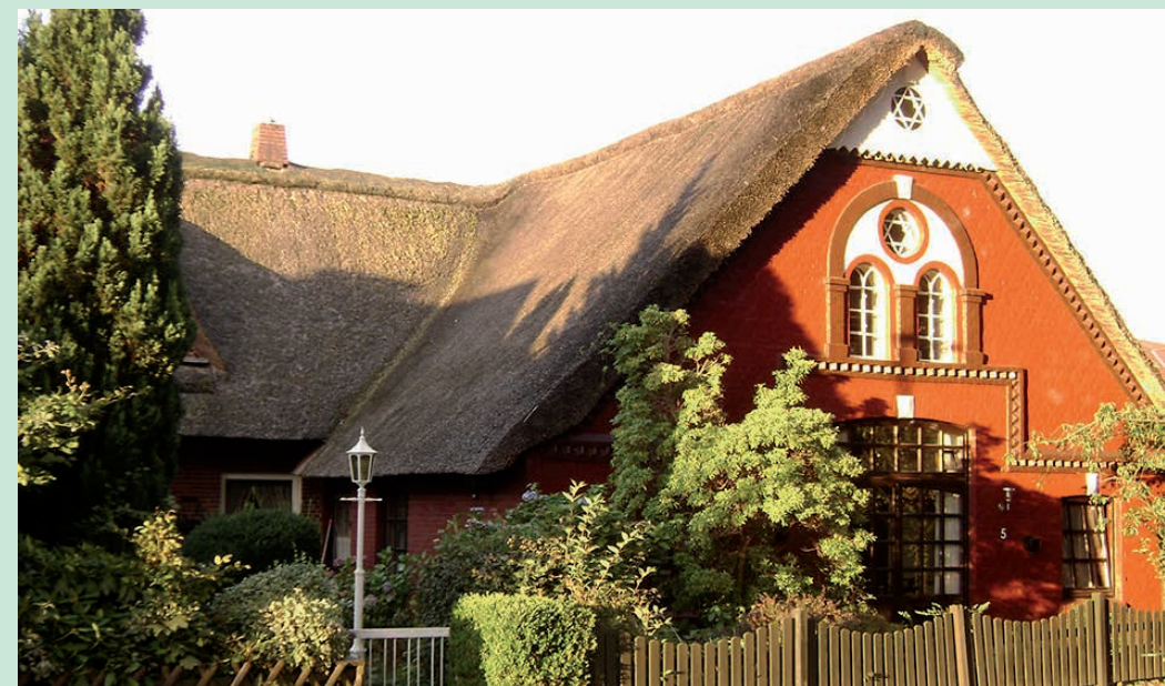
Wenn von alten Häusern mit Charme die Rede ist, dürfte eins dabei nicht fehlen, das wunderschöne Reetdachhaus mit seiner imposanten Eingangstür und der wunderschön gestalteten Fensterfassade in der Nedderstraße Nr. 5. Es stand gleich hinter dem alten Bauernhaus in der Hauptstraße 84. Das Haus aus dem Baujahr 1850 kam über den Vorbesitzer Krohn im Jahr 1927 in den Besitz des Schäfers Johann Alpers, der aus Bahrenfeld nach Schenefeld gekommen war. Im Volksmund wurde das Haus „Schäper-Hus“ genannt. F.G.
