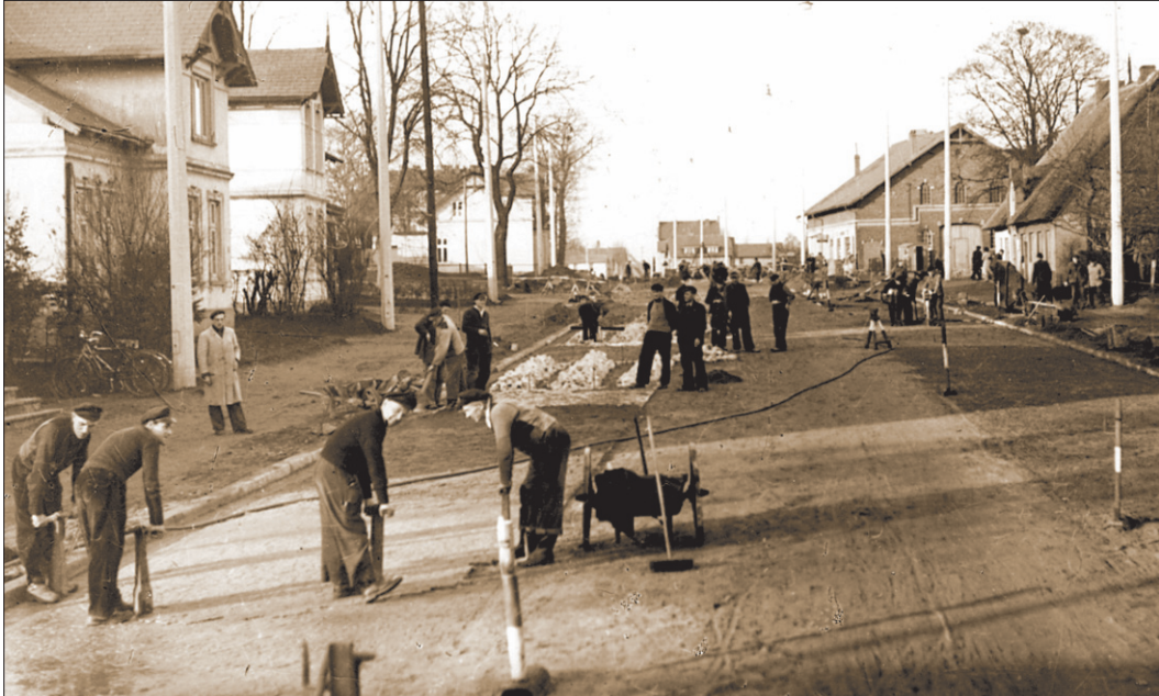
Die Straßenbauer und Steinsetzer schufen eine Prachtsstraße in Lurup. Kleingranit und Pflastersteine wurden verarbeitet. Das Foto entstand auf der Luruper Hauptstraße/Ecke Lüttkamp.
